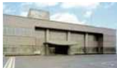
▲新潟県放射線監視センター 新潟県柏崎刈羽原子力防災センター (柏崎市三和町)
