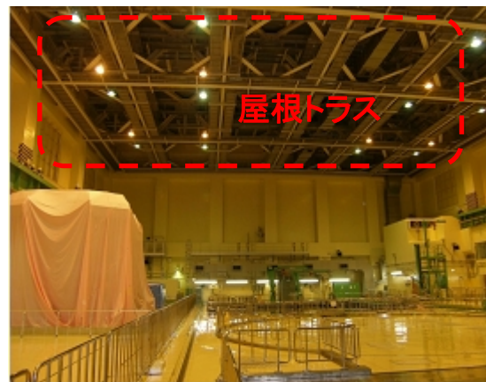
原子炉建屋 屋根トラス
