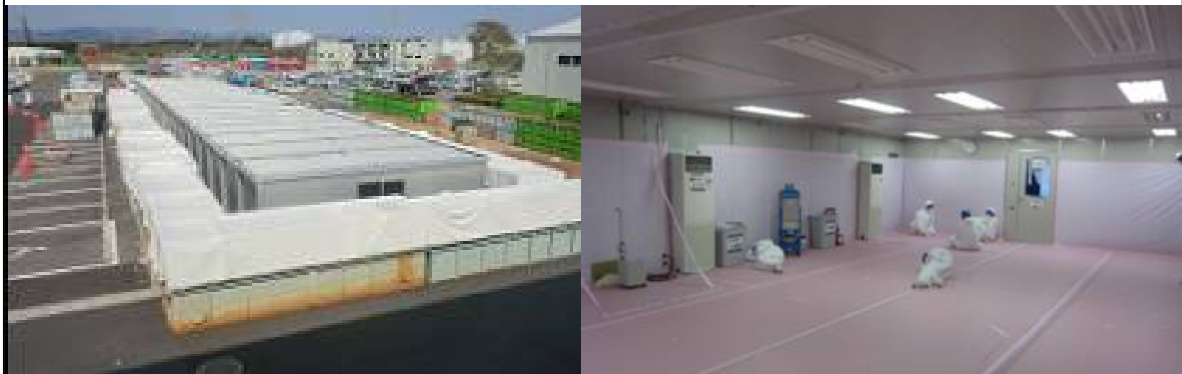
現場休憩施設外観(左)と内観(右)
