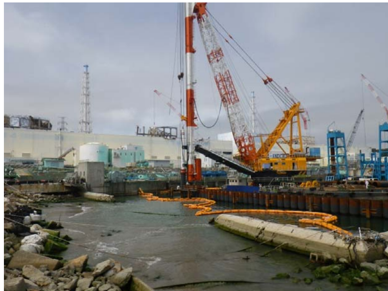
鋼管矢板打設置状況
