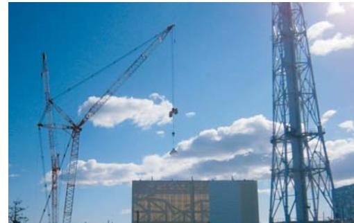
1号機原子炉建屋上部の空気中の放射性物質濃度の測定
