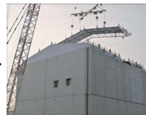
屋根パネル設置（10月14日）
