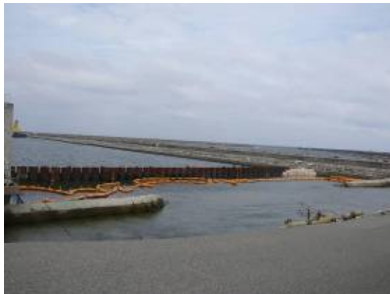
鋼管矢板設置状況
