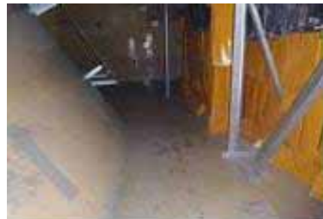
鋼製支柱設置前(5/31撮影)
