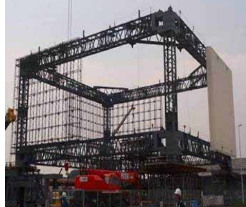
小名浜港における仮組状況(8/10時点)
