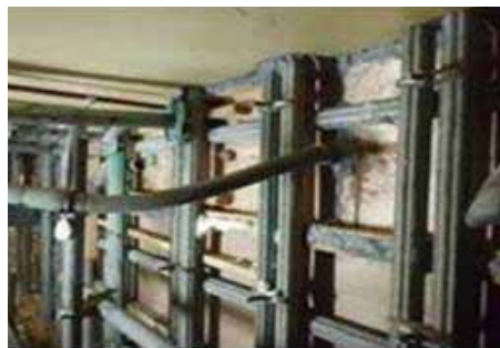
グラウト注入状況(7/30撮影)
