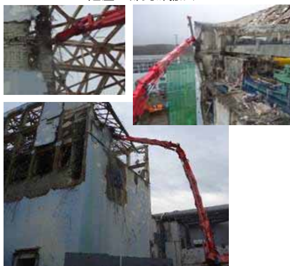
建屋上部瓦礫撤去
