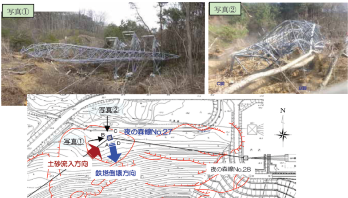
【図2：鉄塔の倒壊状況】
