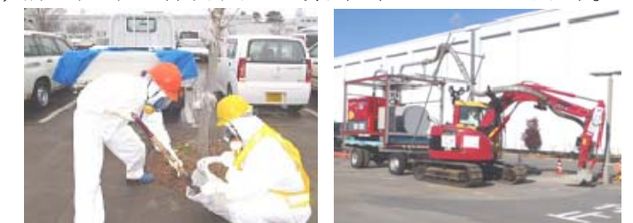
図3. 免震重要棟前面線量低減の様子
