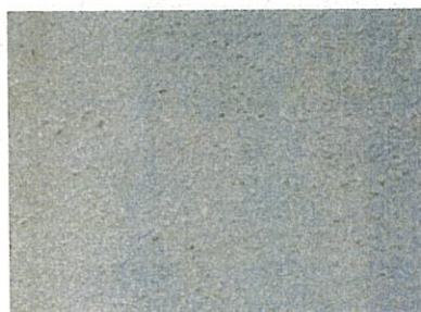
⑤ 西面（外壁）
