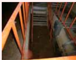
3号機階段室（北西）
