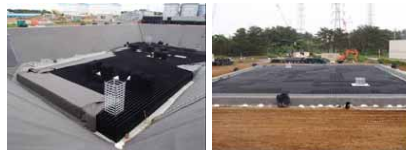
図2：地下貯水槽設置状況
