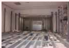
ゲートモニタ室床鉄骨組状況
