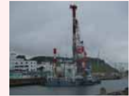
遮水壁先行削孔準備作業状況
