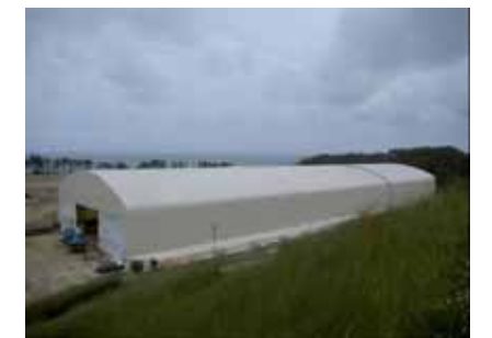
図5：覆土式一時保管施設準備工事完了（1槽目：H24.6.13撮影）
