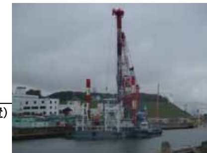
図4：遮水壁先行削孔作業準備状況（H24.6.22撮影）
