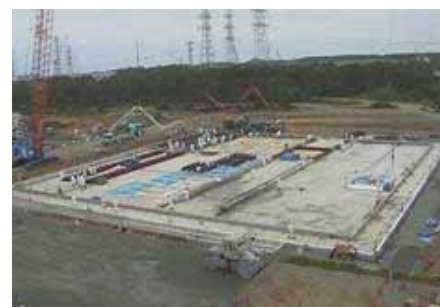
図1：多核種除去設備基礎施工状況
