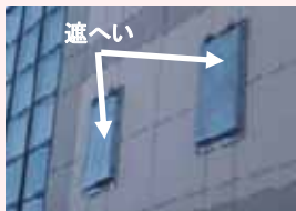
鉛材による窓部遮へい状況
