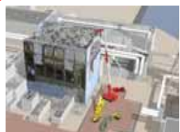
原子炉建屋上部のガレキ撤去
