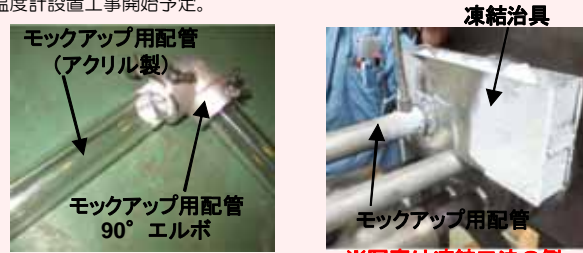
配管挿入試験
