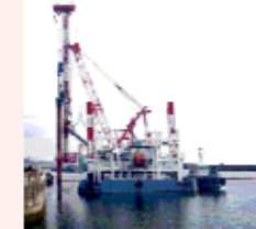
遮水壁先行削孔 作業状況
