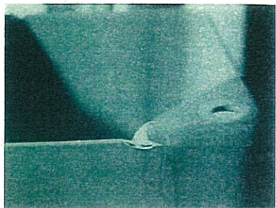
K5 剥離状況 (V89H567)
