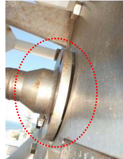
主排気筒との接続部(側面より)
