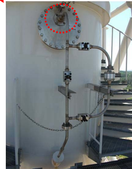
主排気筒との接続部(正面より)
