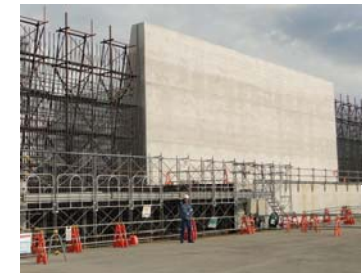
③3号機海側 (8月28日撮影)
