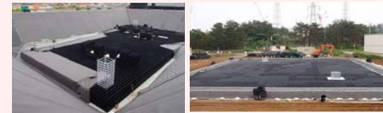
地下貯水槽設置状況
