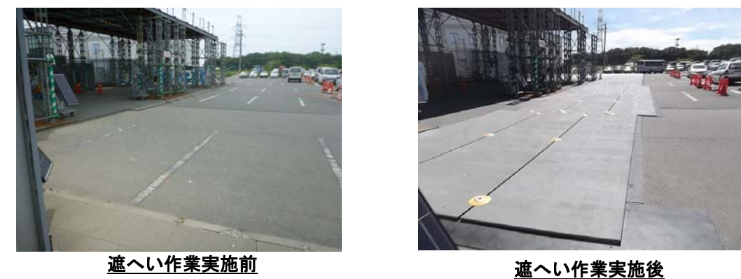
図3：通勤バス待機場所の遮へい作業の様子
