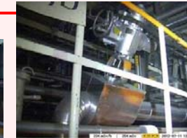
格納容器側状況
