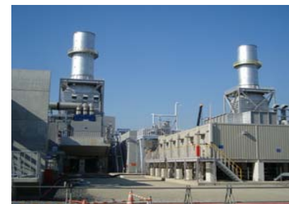
千葉火力発電所 (GT3台)
