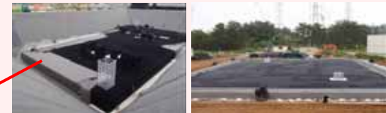
地下貯水槽設置状況
