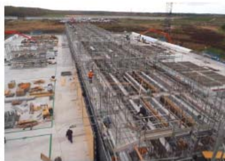
内部足場・支保工組立状況 （2012.11.10）
