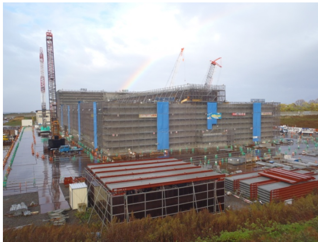
工事状況全体写真（2012.11.10）
