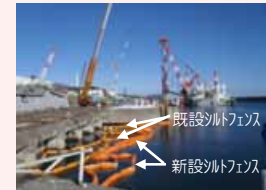
シルトフェンス交換の様子
