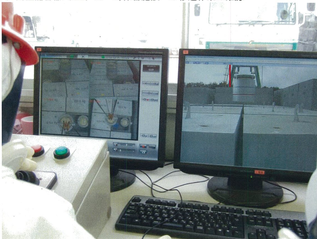
(7) 高性能容器 (HIC) の一時保管施設への移送作業の確認
