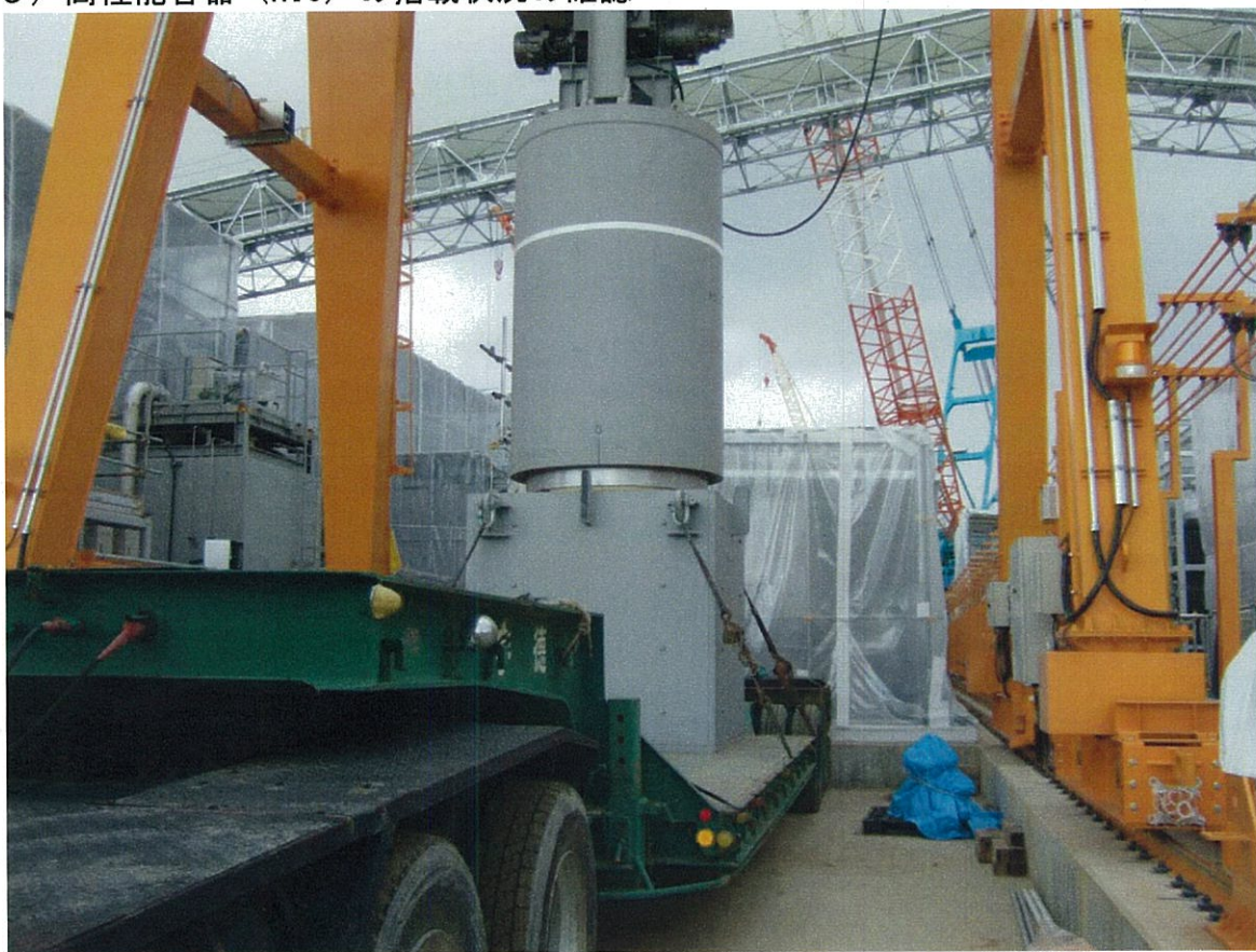
(5) 高性能容器 (HIC) の搭載状況の確認
