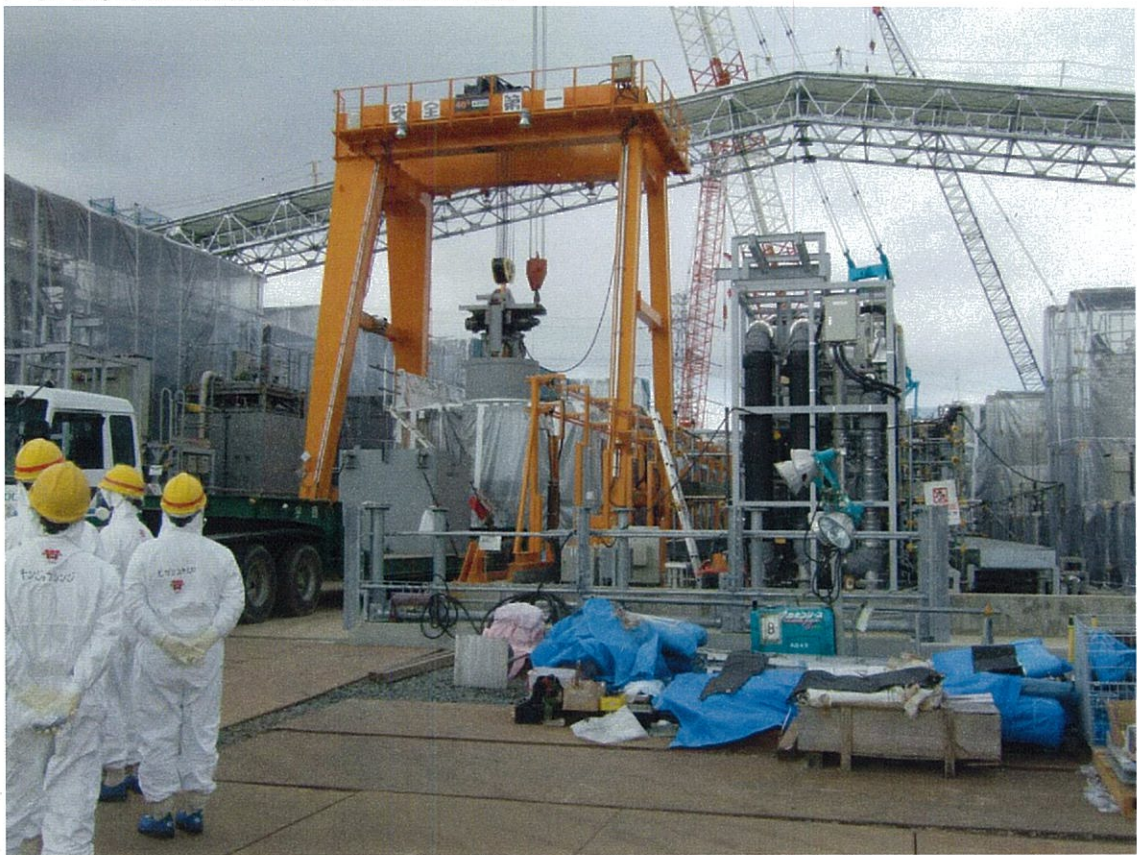
(3) 多核種除去設備の建設状況の確認
