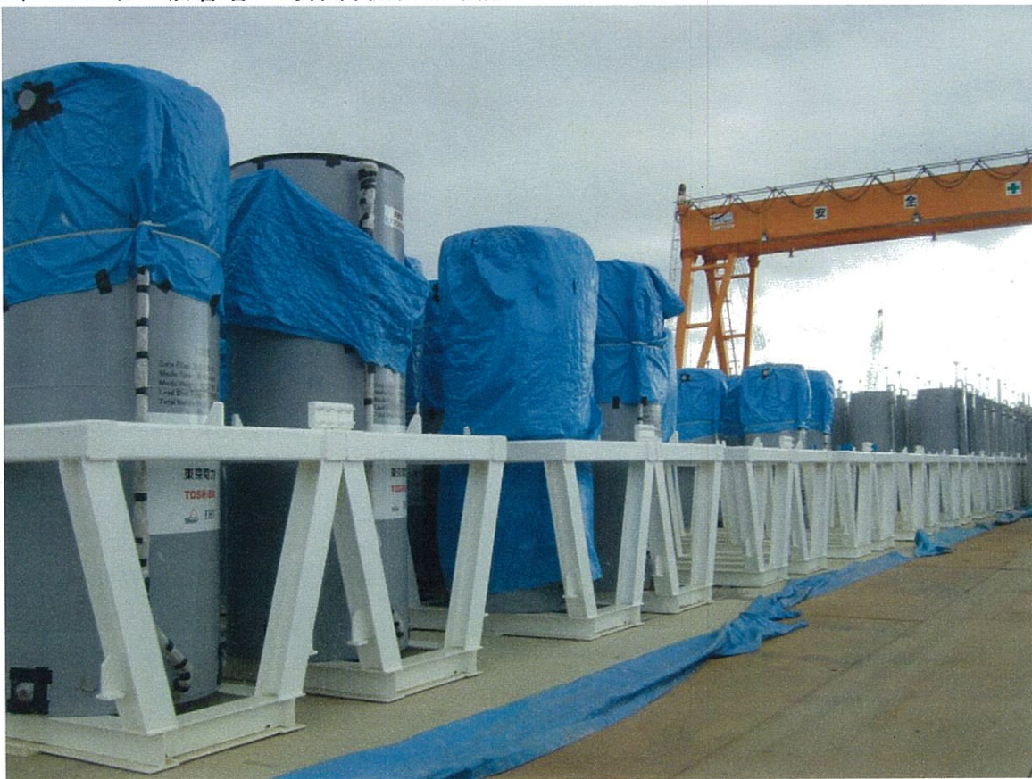
(8) セシウム吸着塔一時保管状況の確認
