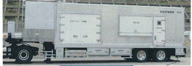
電源車の高台への設置等
