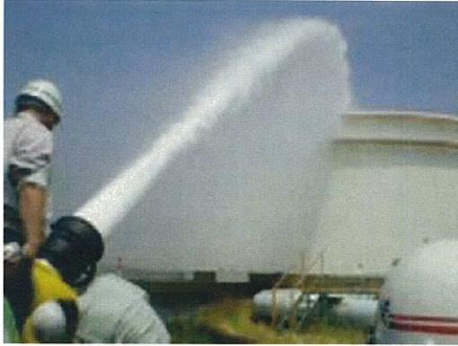
大容量泡放水砲システム
