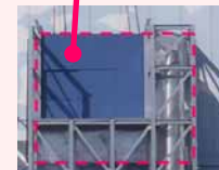
閉止パネル設置完了後
