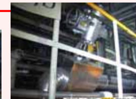
格納容器側状況
