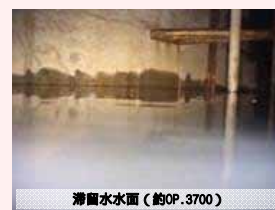
1号機トラス室内部調査の様子
