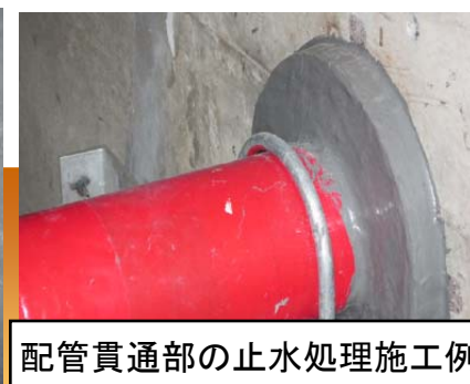
止水処理: 重要機器室への浸水防止(約300箇所)
