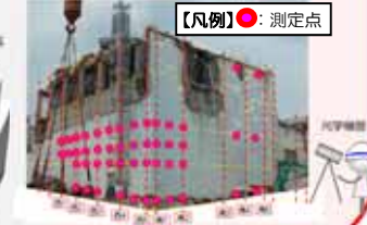
傾きの確認(外壁面の測定)
