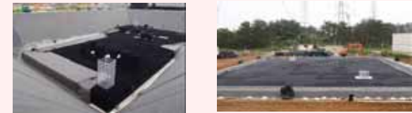
地下貯水槽設置状況
