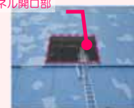
閉止パネル設置前
