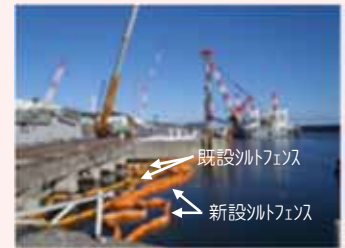
シルトフェンス交換の様子
