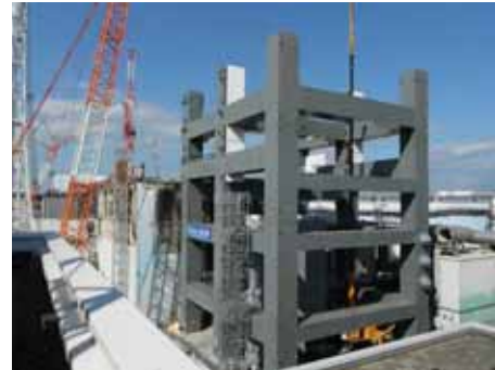
鉄骨建方3節目完了・4節目着手済(3/26撮影)
