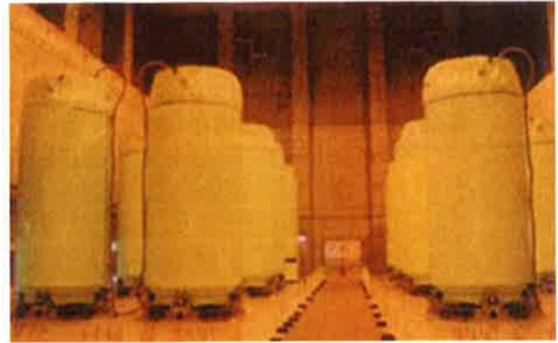
日本原子力発電(株)東海第二発電所での乾式貯蔵 発電所敷地内に貯蔵施設を新設した例
