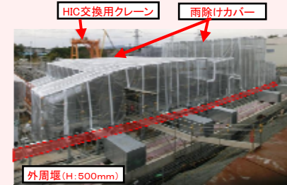
ALPS設置エリアの全景（2012/11/17）
