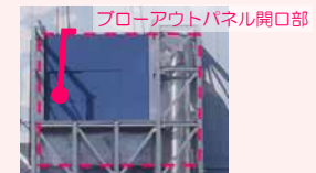
閉止パネル設置完了後
