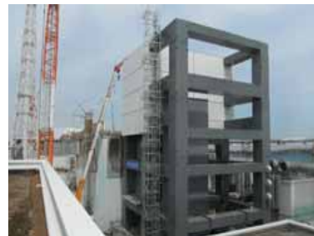
鉄骨建方実施状況(4/23撮影)
