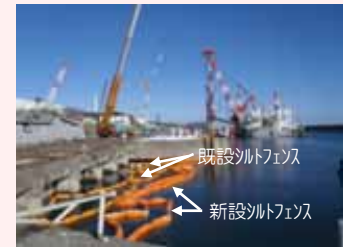
シルトフェンス交換の様子
