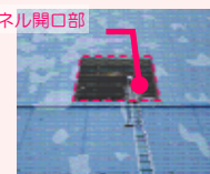
閉止パネル設置前
