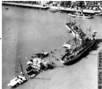
スエズ運河封鎖時に沈められた船
