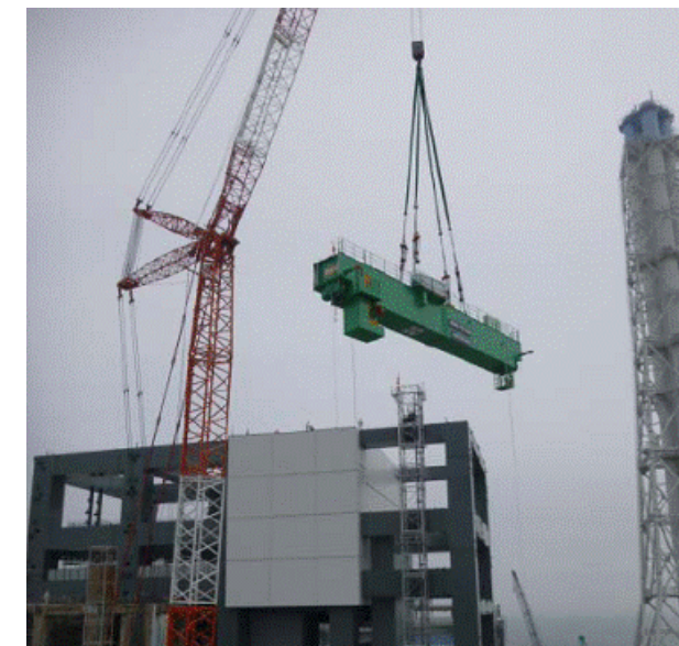
図5：4号機天井クレーン吊り上げ作業
