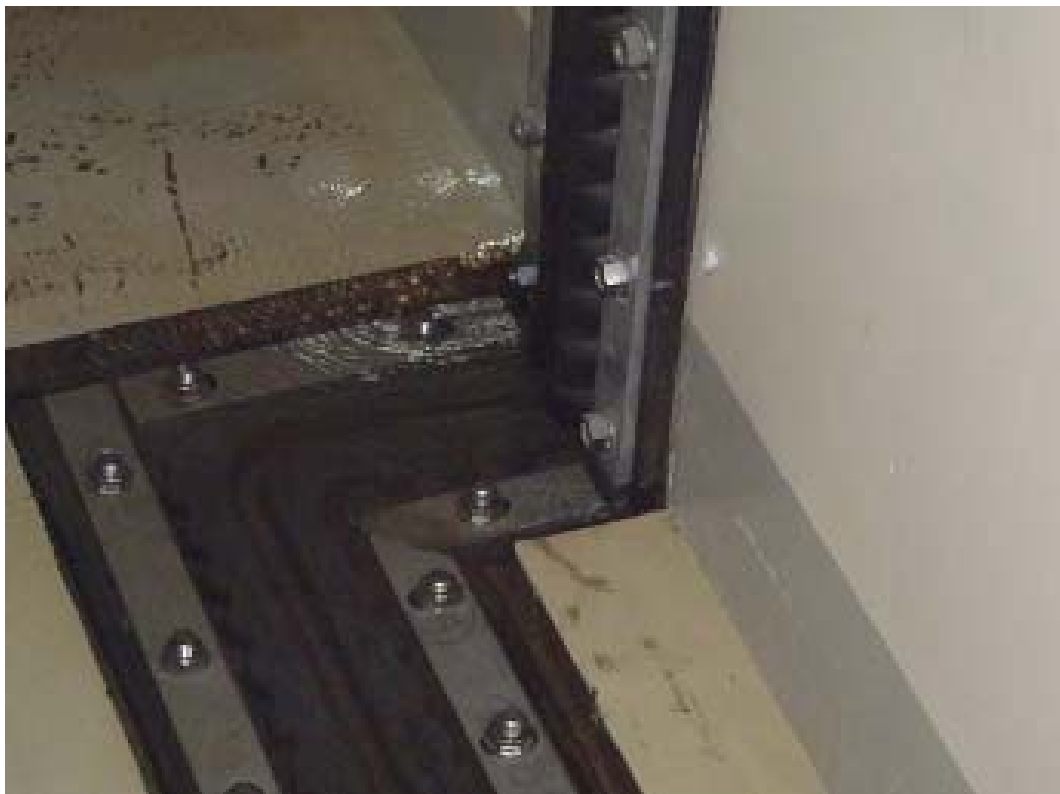
配管トレンチ室 (雨水の流入箇所)
