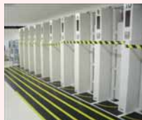
入退域管理施設内部
