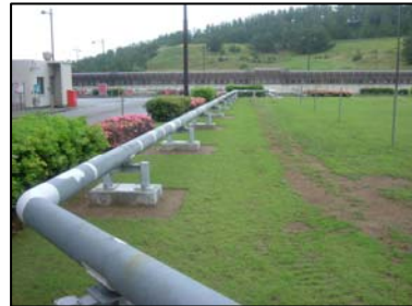
消火配管の地上化
