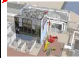
原子炉建屋上部のガレキ撤去
