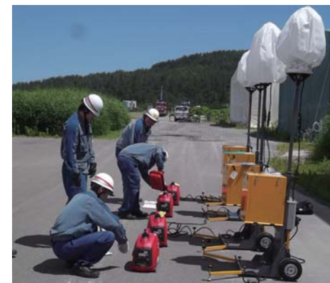
緊急用照明装置の点検
