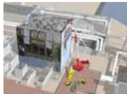
原子炉建屋上部のガレキ撤去
