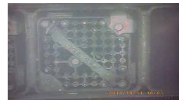
ガレキ吸引作業後
