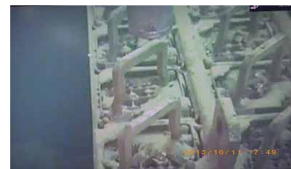
ガレキ吸引作業前
