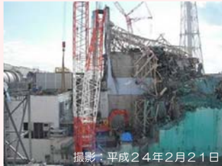
撮影:平成24年2月21日 大型ガレキ撤去前
