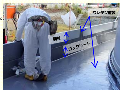
<鋼材による高上げ状況>
