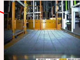
南東マンホール
