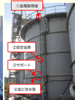
<雨樋設置状況>
