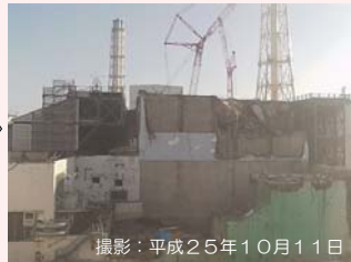
撮影:平成25年10月11日 大型ガレキ撤去後
