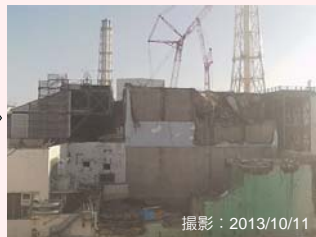
大型ガレキ撤去後
