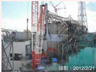
大型ガレキ撤去前
