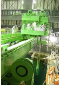
燃料取り出し状況
