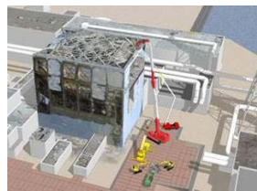
原子炉建屋上部のガレキ撤去
