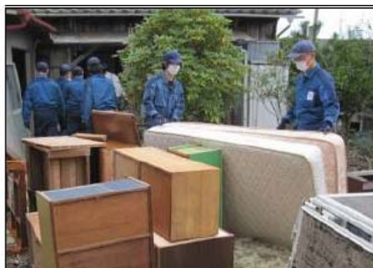
【住宅の清掃作業】
