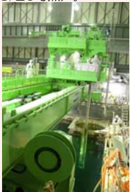
燃料取り出し状況
