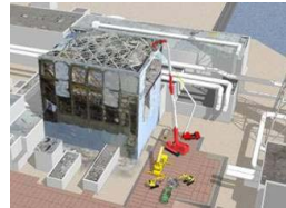
原子炉建屋上部のガレキ撤去
