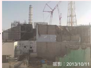
大型ガレキ撤去後
