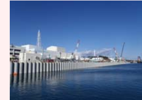
海側遮水壁工事状況
