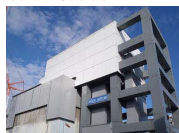
【外観(燃料取出し用カバー)】
