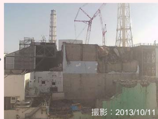
大型ガレキ撤去後
