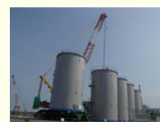
< 陸揚げされたタンク >
