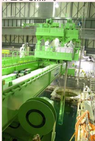
燃料取り出し状況
