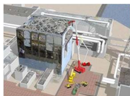
原子炉建屋上部のガレキ撤去
