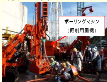
<陸側遮水壁 凍結管設置工事状況>
