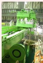
燃料取り出し状況
