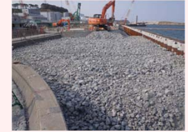
海側遮水壁工事状況 (1号機取水口側埋立状況)
