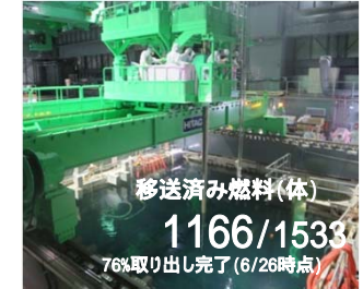
(燃料取り出し状況)
