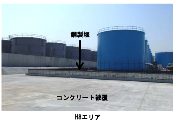
図2: タンク堰二重化・堰内塗装工事状況
