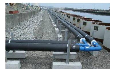
地下水ドレン配管設置状況
