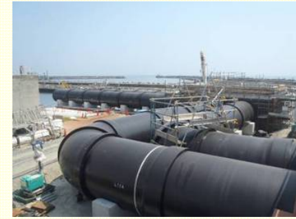
<配水管設置状況>
