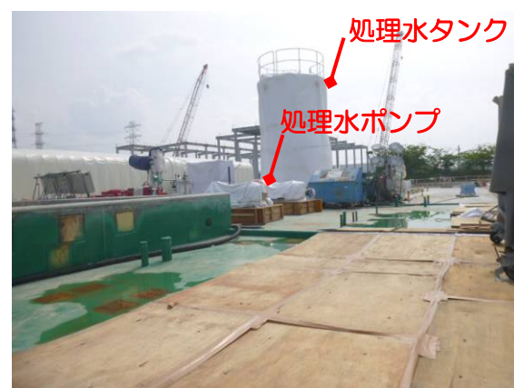
図4：高性能多核種除去設備 機器据付状況
