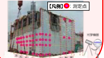
傾きの確認（外表面の測定）
