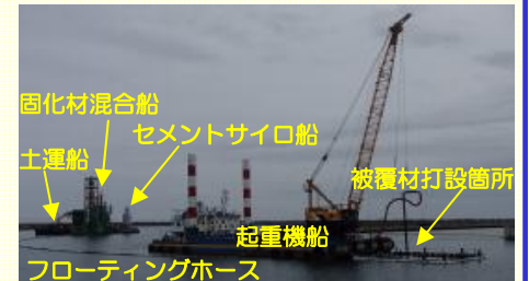
<港湾内被覆作業の様子>
