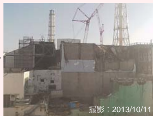
大型ガレキ撤去後
