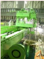
燃料取り出し状況
