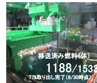
※クレーン点検のため7/1～9月上旬まで作業中断 (燃料取り出し状況)
