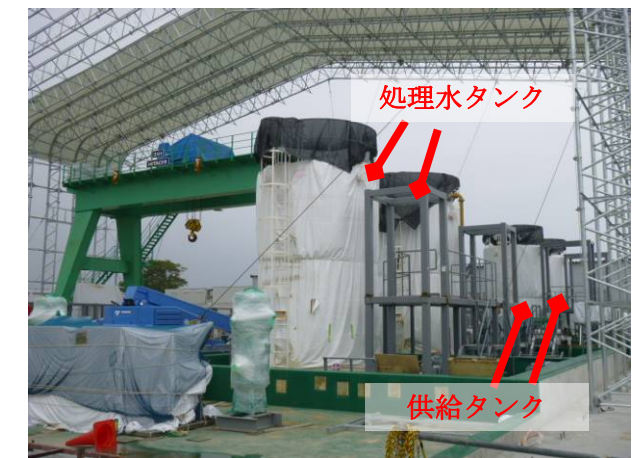
図4：高性能多核種除去設備 機器据付状況
