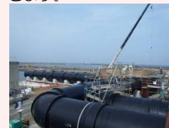
配水管設置状況①
