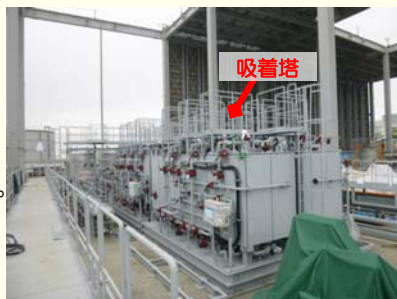
<増設多核種除去設備 設置状況>
