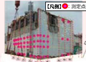
傾きの確認(外表面の測定)
