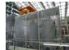
(放射性物質を吸着する設備の設置状況)
