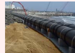
配水管設置状況②
