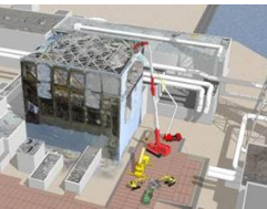
原子炉建屋上部のガレキ撤去
