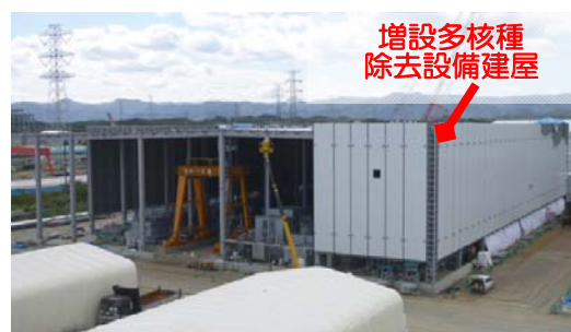
図4：増設多核種除去設備 建屋全景
