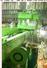
燃料取り出し状況
