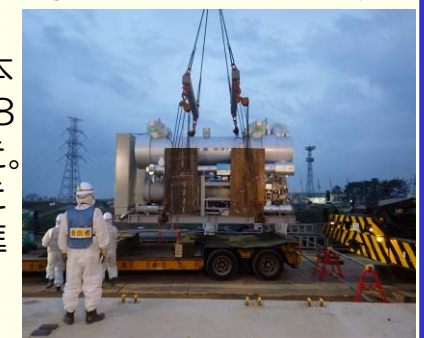
<凍結用冷凍機の設置作業>
