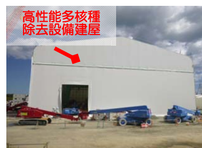
図5：高性能多核種除去設備 建屋全景
