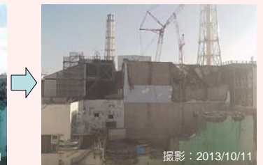
大型ガレキ撤去後
