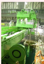
燃料取り出し状況
