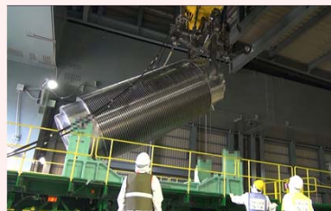
構内用輸送容器のトレーラへの積み込み
