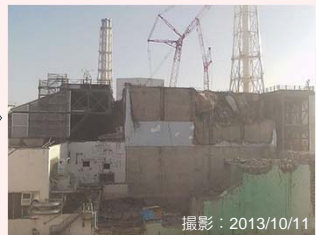
大型ガレキ撤去後
