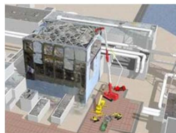
原子炉建屋上部のガレキ撤去
