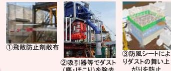
①飛散防止剤散布 ②吸引器等でダスト(塵・ほこり)を除去 ③防風シートによりダストの舞い上がり防止 ④モニターを追加設置してダスト監視体制を強化
