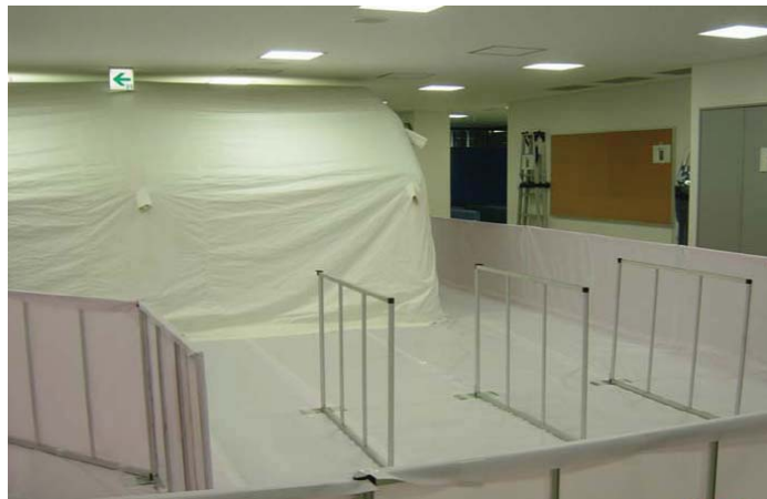
免震重要棟出入口における チェンジングスペースの設置
