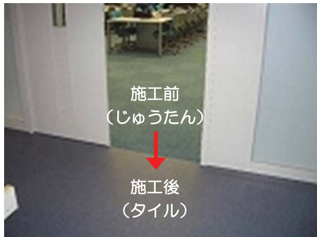
免震重要棟内の床材
