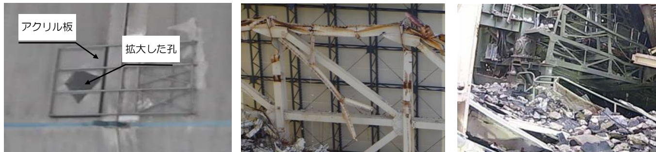
図9：1号機原子炉建屋上部 屋根パネル孔塞ぎ状況およびガレキ調査状況
