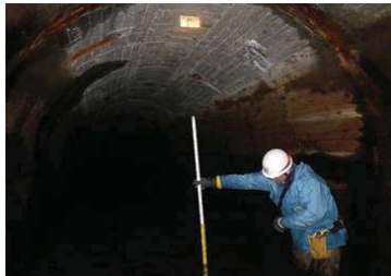
写真-1:水路の調査・点検
