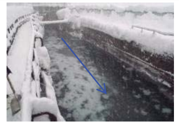
写真-1:シャーベット状の雪の流入(導水路入口部)
