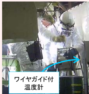
2号機原子炉圧力容器故障温度計 引抜作業状況
