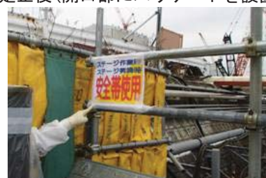
是正後（安全帯使用の標識を設置）
