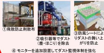
①飛散防止剤散布 ②吸引器等でダスト（塵・ほこり）を除去 ③防風シートによりダストの舞い上がり防止 ④モニターを追加設置してダスト監視体制を強化
