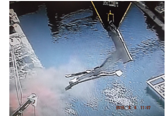
(2015/3/6: 燃料交換機西側フレーム撤去作業状況)
