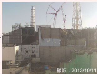
大型ガレキ撤去後
