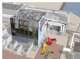
原子炉建屋上部のガレキ撤去
