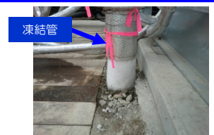
(陸側遮水壁 試験凍結箇所例)
