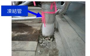
(陸側遮水壁 試験凍結箇所例)
