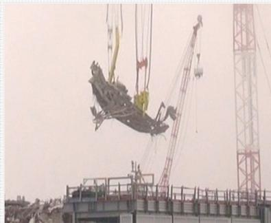
＜燃料交換機撤去作業の状況＞
