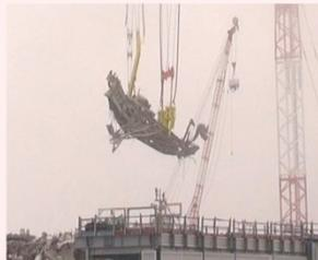
8/2 燃料交換機撤去作業の様子
