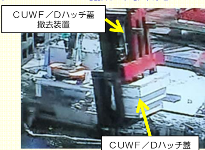
<CUWF/Dハッチ蓋撤去作業状況>
