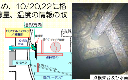
<格納容器内部調査状況>
