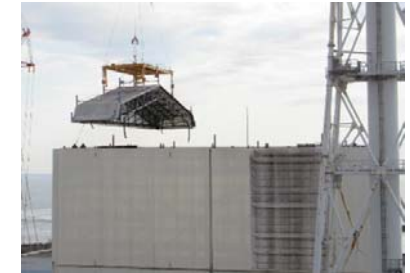
(1号機建屋カバー解体作業の状況)
