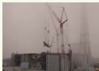
3号機 大型瓦礫（燃料交換機）吊り上げ
