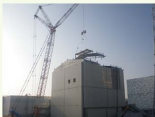
1号機 建屋カバー解体（屋根取り外し）
