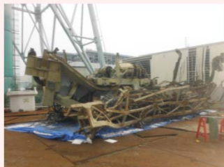
撤去した燃料交換機
