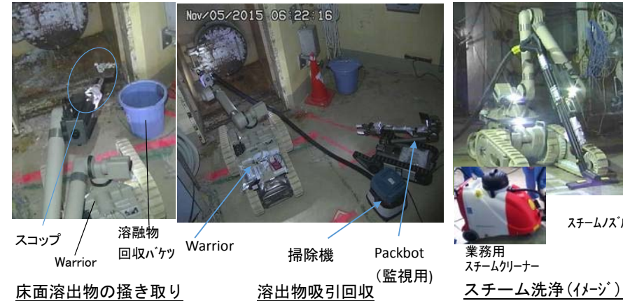
図5：2号機X-6ペネ周辺除染状況
