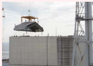
屋根パネル取り外し状況
