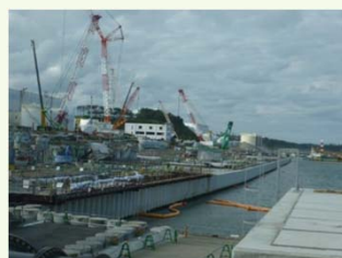
海側遮水壁矢板打設作業の再開
