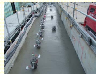
<陸側遮水壁海側 凍結管設置状況>
