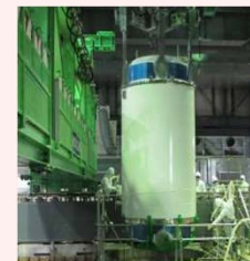
燃料取り出し状況
