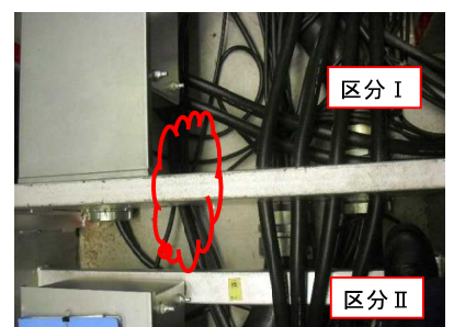
5号機 分離バリア貫通 (保護管なし)
