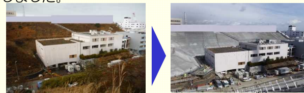
<フェーシング工事の状況>
