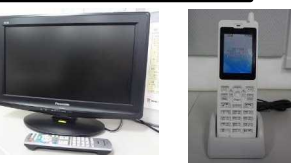
テレビやPHSの設置工事
