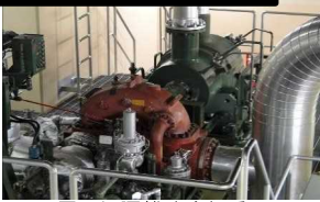
原子炉隔離時冷却系
