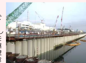
海側遮水壁 鋼管矢板打設完了状況
