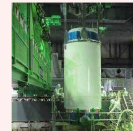
燃料取り出し状況
