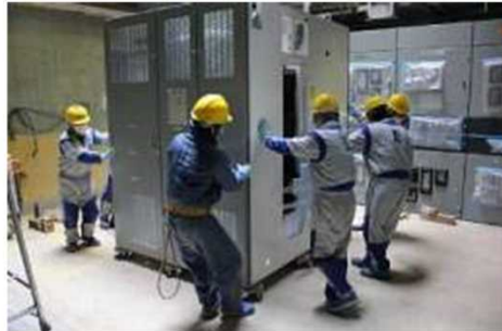
1号機 電源盤 (P/C 1C-1) 据付作業
