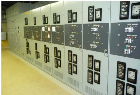
1号機 電源盤 (P/C 1C-1) 据付後
