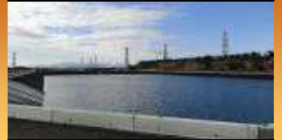
淡水貯水池設置
