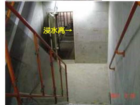
3号機 海水熱交換器建屋 地下1階⇄1階 復旧状況
