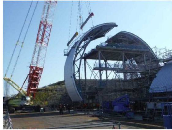
3号機燃料取出用カバー 組み立て訓練状況
