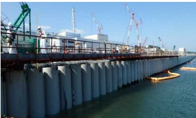
海側遮水壁設置状況
