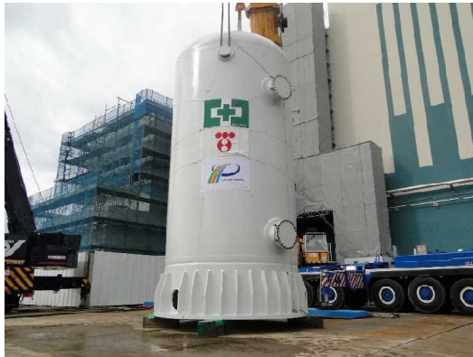
フィルタベント用のフィルタ装置 (粒子状物質、無機ヨウ素除去)
