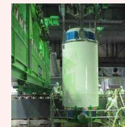
燃料取り出し状況
