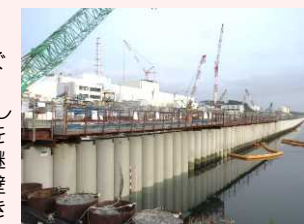
海側遮水壁 鋼管矢板打設完了状況
