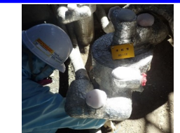
(凍結管への水の付着状況)
