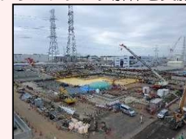
H1東エリア解体後の様子
