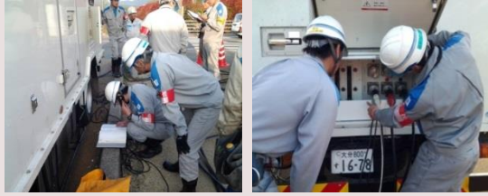
（電源車による電源の復旧・通電）
